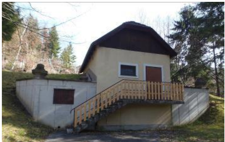
Der Hochbehälter am Kalvarienberg fasst 500 m 3 Wasser
