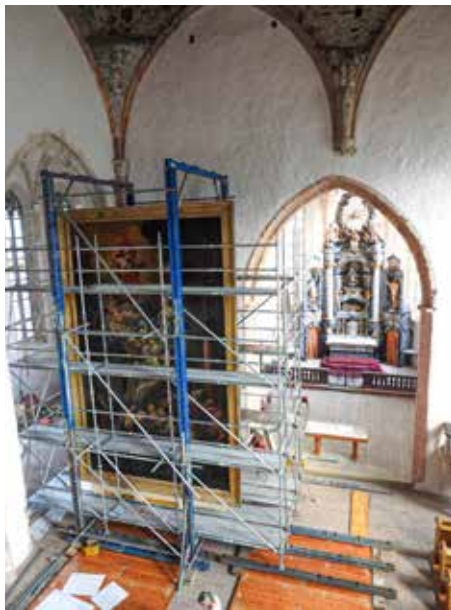
Ein Spezialgerüst der Firma Doka hält Bild und Rahmen stabil in einer aufrechten Position.
