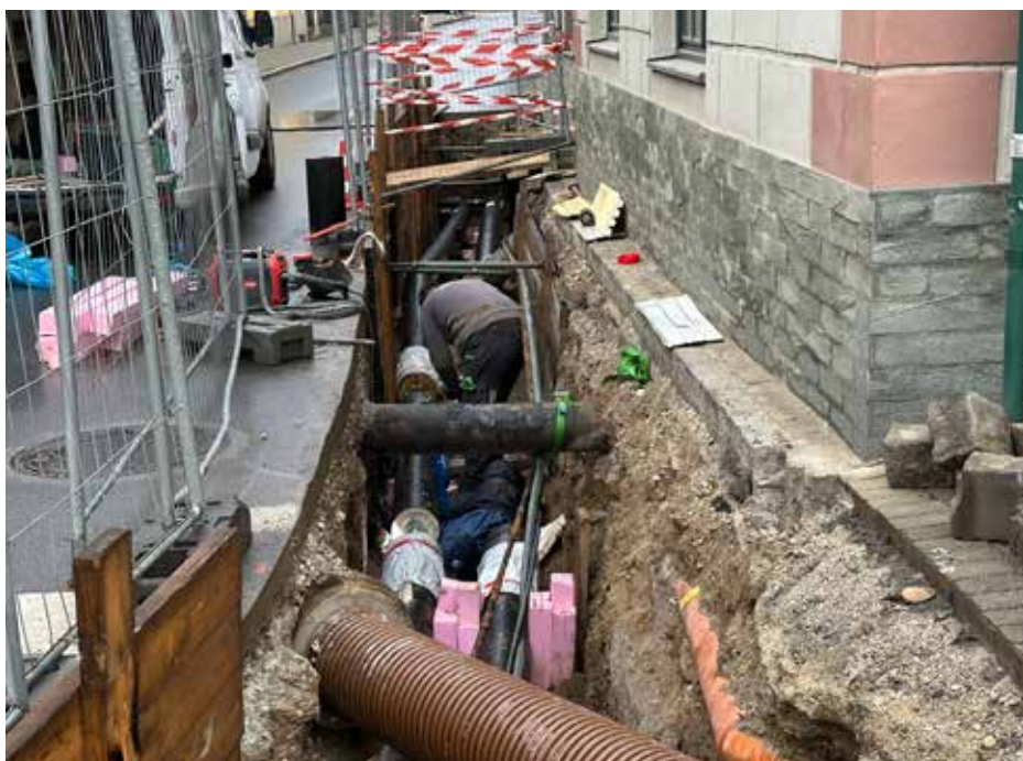
Verlegung Fernwärme auf der Landesstraße 134 vor dem Haus Burger.
