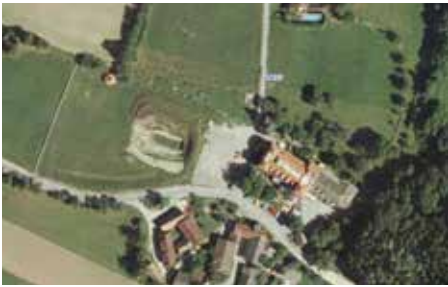
2007 - Verlegung Straße beim Molzbachhof
