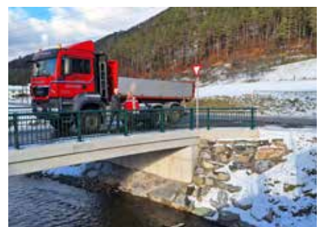
2023 - Neubau Burger Brücke
