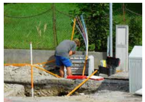
2023 - Breitbandausbau im Ortsgebiet
