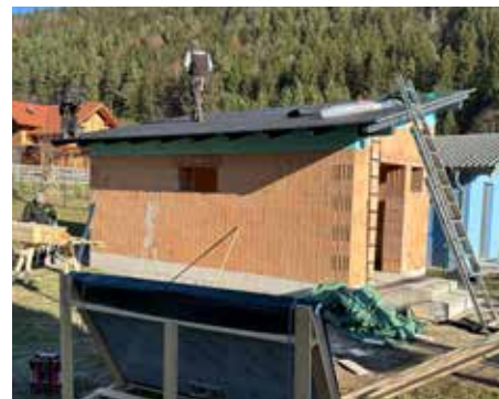
Das neue Technikgebäude beim Bauernwiesenbrunnen entsteht. Hier wird die Mess-, Steuer- und Regeltechnik eingebaut.
