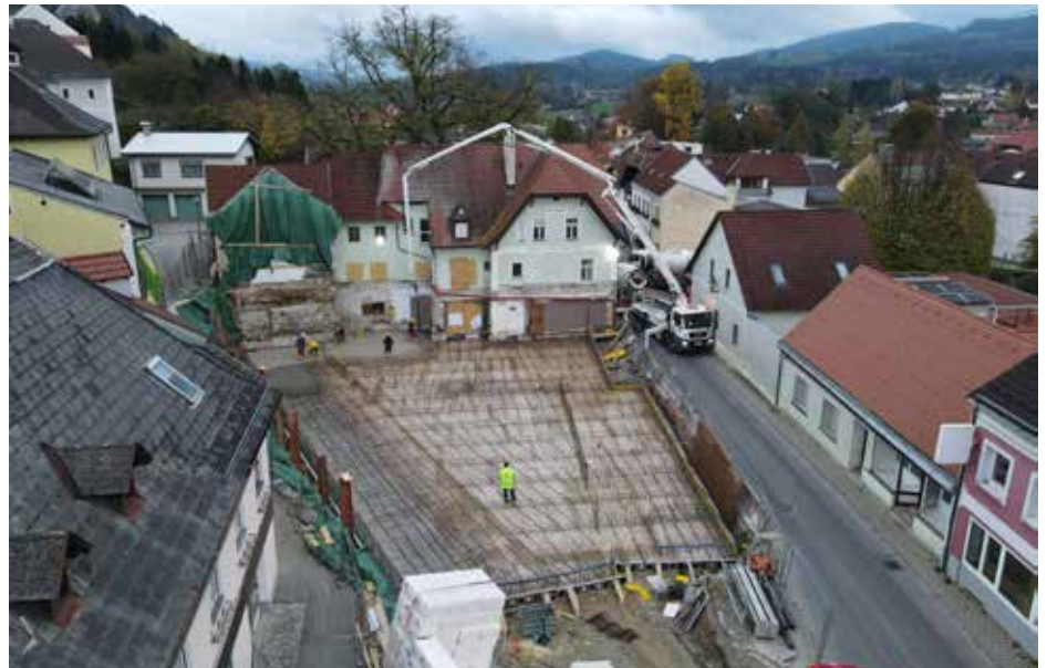
2024 - Neubau des Lindensaals
