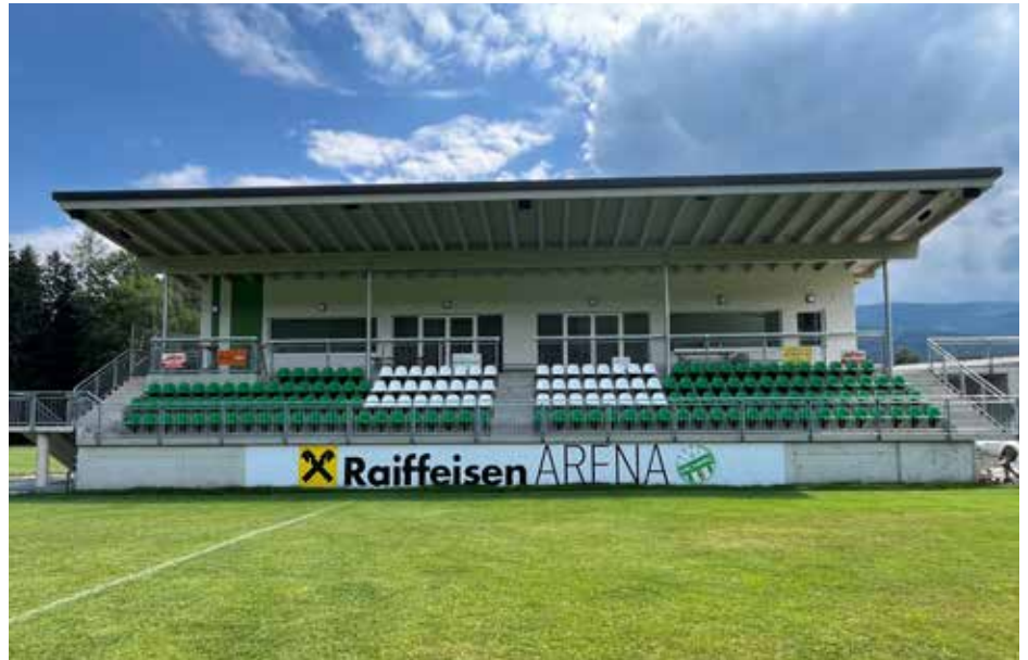
2024 - Neubau des USV-Vereinsgebäudes
