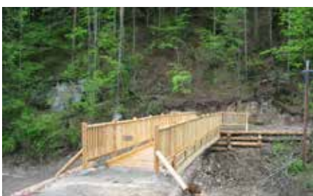
2006 - Errichtung Brücke zur Hermannshöhle
