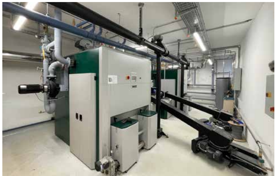
2024 - Erneuerung des Heizwerks in der Volksschule
