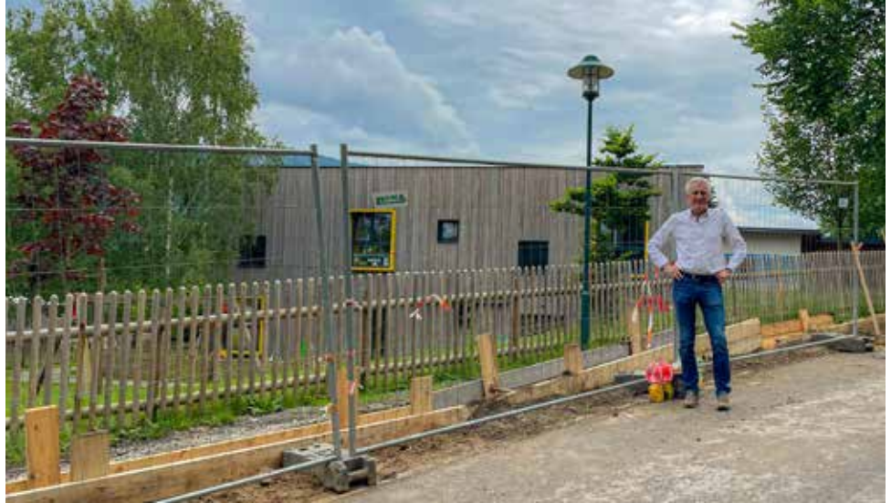
Bgm Dr. Willibald Fuchs vor der Wärmenetz-Künette vor dem Kindergarten - rote Linie im Plan
