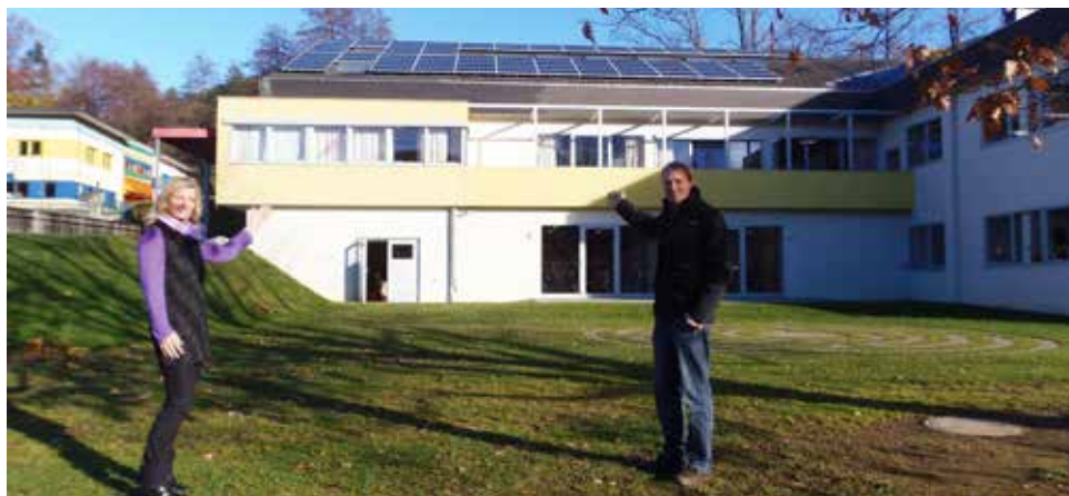
Dir. Brigitte Fuchs und Vzbgm. Hubert Haselbacher vor der im Jahr 2011 errichteten PV-Anlage in der Volksschule.
