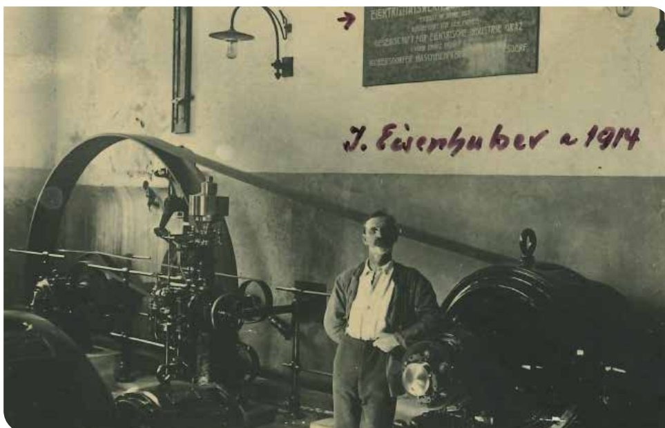
Julius Eisenhuber, geb. 1866, vor dem Stromgenerator
