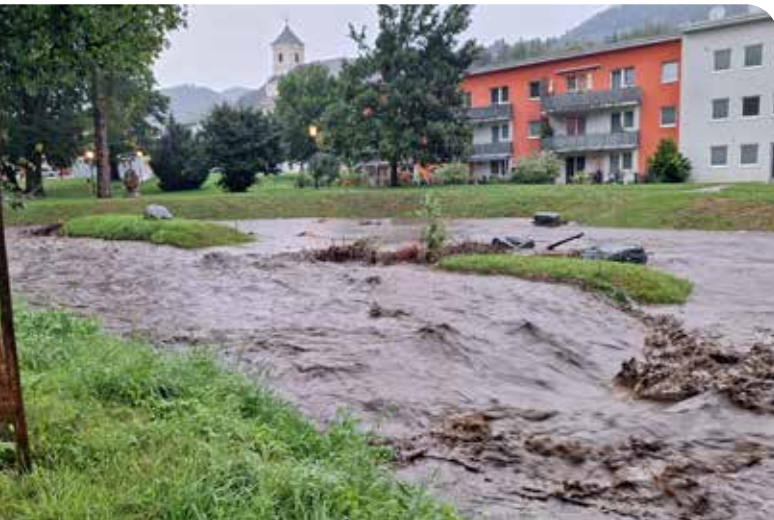
Doppelter Nutzen des Retentionsraumes beim Park: Bei Hochwasser dient er als Überlaufbecken, ...
