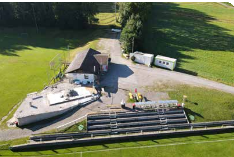
Mit den Vorbereitungsarbeiten für den Kabinenneubau des USV Kirchberg wurde bereits in den Sommermonaten begonnen.
