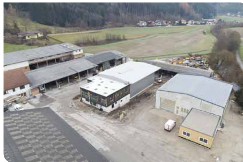
Das Betriebsgebiet auf der Au wächst. Rechts die Halle der Maschinenbaufirma Rehberger, in der Mitte die Produktionshalle der Zimmerei von Ing. Christof Wetzelberger - Bausteff Holzbau GmbH
