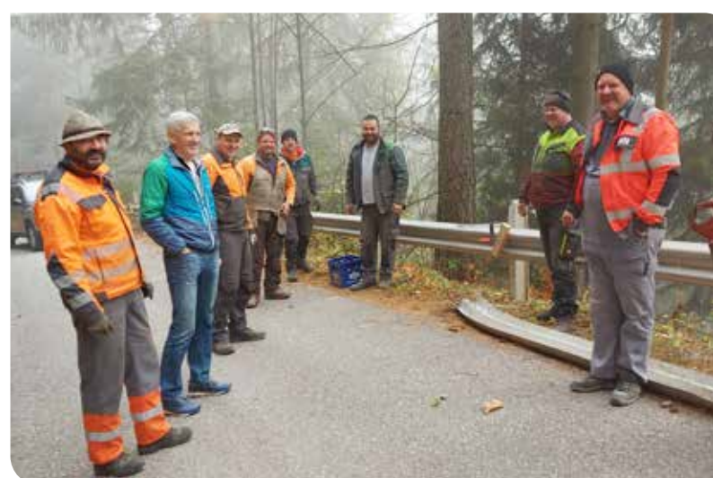
Am Güterweg Molzegg wurde eine gefährliche Stelle mit einer Leitschiene abgesichert. Die tatkräftigen Mitglieder der Weggemeinschaft haben die neue Leitschiene selbst aufgestellt und erstklassig ausgeführt!
