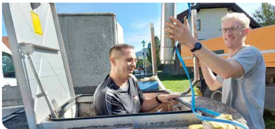
Wolfgang Schabauer und Michael Gludowatz beim Einbau der neuen Pumpe.
