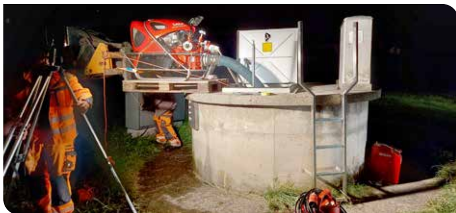
Notversorgung mittels Feuerwehrrampe während der Nachtstunden.
