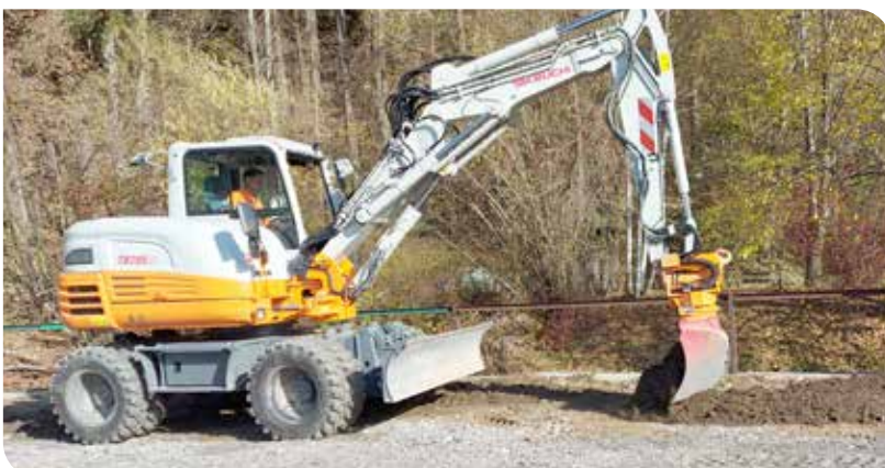
Bagger mit Fahrer Michael Morgenbesser beim Anlegen eines Grünstreifens beim neuen Busparkplatz der Firma Retter.
