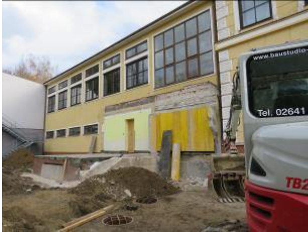
Begonnen wurde mit Abbrucharbeiten an der Westseite
