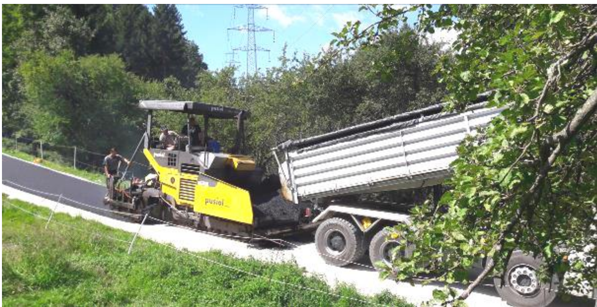
Insgesamt wurden dieses Jahr in Kirchberg Güterweginstandhaltungsmaßnahmen im Wert von Euro 270.000 umgesetzt. Im Bild Asphaltierungsarbeiten am Güterweg Nebelsbach.
